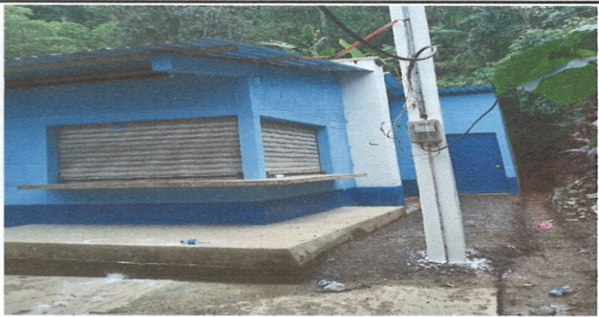
Foto 5: Instalación de chimenea con ladrillo
