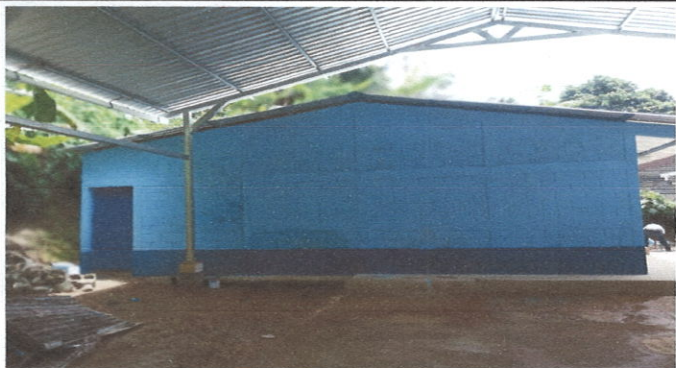
Foto 3: Mejoramiento de bodega de cocina
