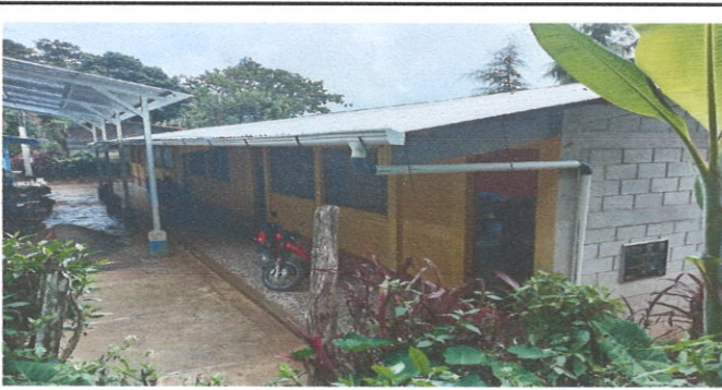
Foto 6: Instalación de canaletas y bajadas
