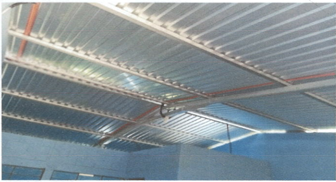
Foto1: Sustitución cubierta de lámina y estructura de techo
